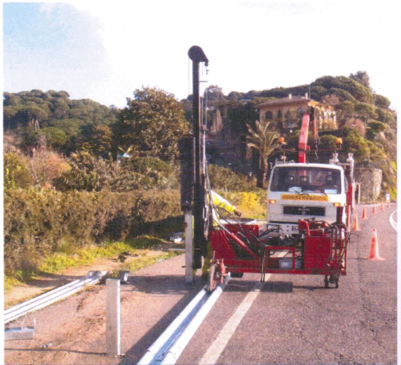
Colocación de barrera metálica.
