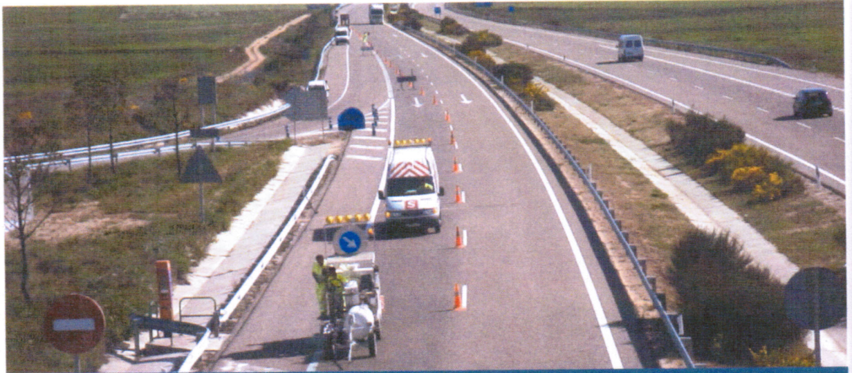
Operaciones de conservación. Señalización horizontal.
